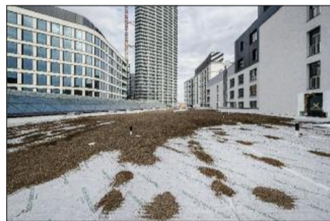
Unter den Grünflächen zwischen den Gebäuden wurde Delta-Floraxx Top als Drän- und Speicherbahn verlegt. Das Bild zeigt die verlegte Bahn mit teilweiser Überschüttung der Vliesüberlappung.
