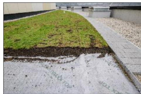
In dem hier gezeigten Bereich zwischen der Glasüberdachung und Gebäude wurden auf der Delta-Floraxx Top bekieste und begrünte Flächen, aber auch Gehwege realisiert.
